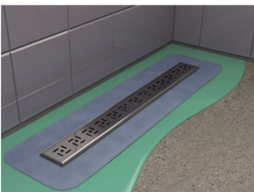
5. Na čerstvou tekutou izolaci položte hydroizolační manžetu.
